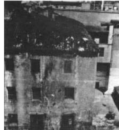
Dstrucción de la cárcel de mujeres de Barcelona por militantes del sindicato de construcción de CNT, en 1936.
